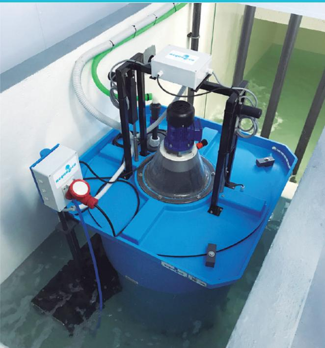
El ajuste automático de la formación de espumas, minimiza el consumo de agua en un circuito cerrado y garantiza una correcta depuración en todo momento
